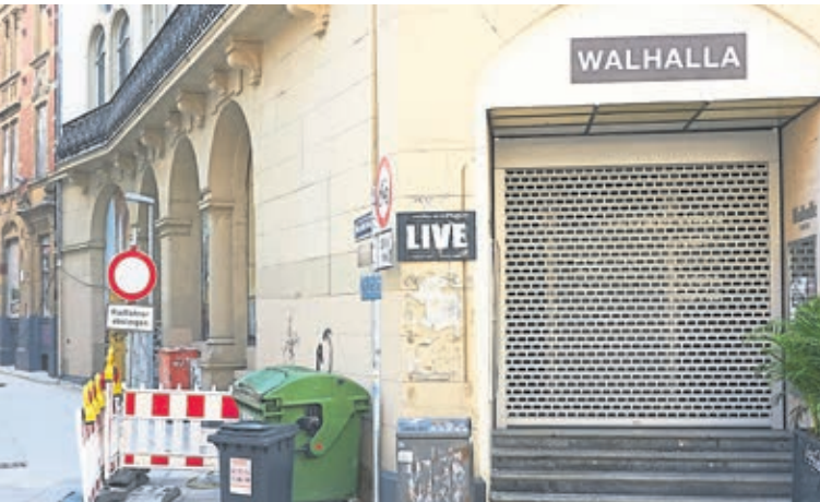
Tore verschlossen, Ausgang offen. Im Walhalla Theater geht seit Anfang 2017 gar nichts mehr, und in der Frage der künftigen Nutzung geht nichts voran.
