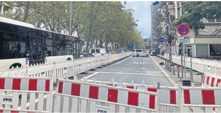
Dauerbaustelle. Bis Ende November wird auf dem Bismarckring gebuddelt.
