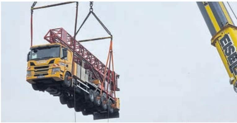
Das „Schicksal“ des einsamen LKW auf der einsturzgefährdeten Salzachtalbrücke bewegte viele Menschen. Nun wurde das so schwere wie teure Gefährt sicher von der Brücke herunter bewegt.
