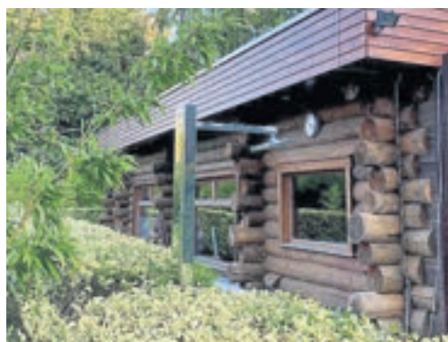
Kelosaua Schlangenbad: In einem großzügigen Holzblockgebäude (ca. 200 qm) aus original finnischem Keloholz befinden sich drei Saunen
